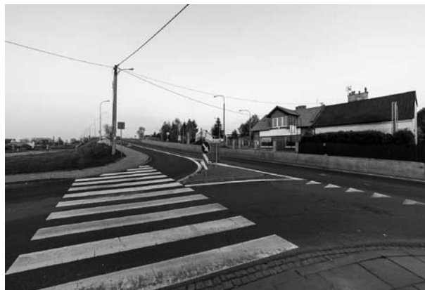
Przebudowana bezkolizyjnego skrzyżowania ul. Krakowskiej z ul. Jagielnia. Rozbudowano DK 44 – ul. Krakowską w celu wykonania pasa prawoskrętu dla dojazdu do ul. Jagielnia wraz z przebudową ul. Jagielnia pod wiaduktem kolejowym. Prace wykonywane były w latach 2009–2010.
